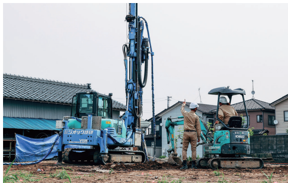
▲戸建住宅における地盤改良工事
