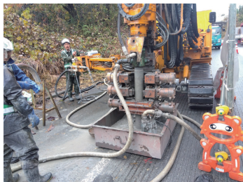
▲ボーリング削孔状況
