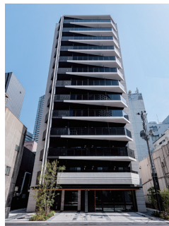
住友商事株式会社 様 （仮称）北区曽根崎新地2丁目計画新築工事（大阪府）
