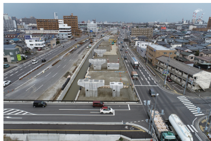
北陸地方整備局 様 栗ノ木道路 栗ノ木高架橋下部(下り・P18-20、ONA2-P2) 工事(新潟県)
