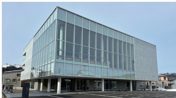
魚沼市 様 魚沼市生涯学習センター建築工事（新潟県）
