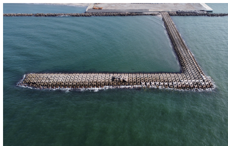
新潟県 様 関屋海岸6年災海岸災害復旧(その2) 工事(新潟県)
