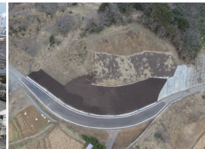
一級市町村道26号線防雪災害(離島市町村代行)道路改良工事(新潟県)
