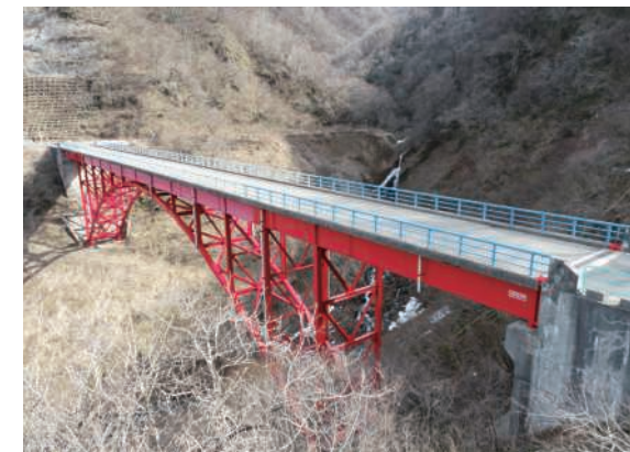
新潟地域振興局 小面谷笹目線道路更新防災（橋梁補修） 塗装塗替工事（新潟県五泉市）
