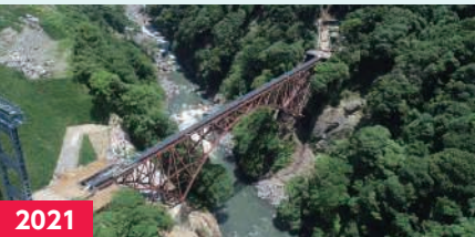
2021 第一白川橋りょう復旧（熊本県）
