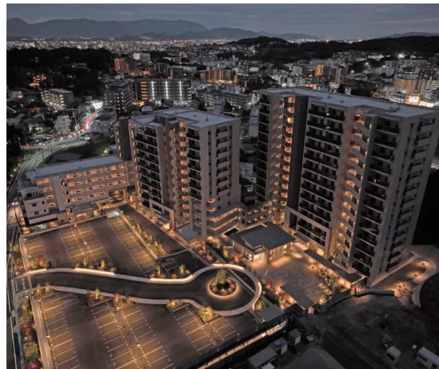
(仮称)エンクレストガーデン福岡新築工事I期工事(福岡県)
