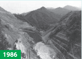
1986 初の大規模ダム工事である破間川ダム
