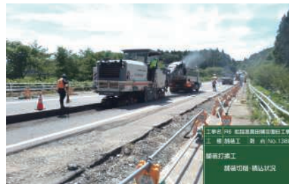
能登復興施工状況
