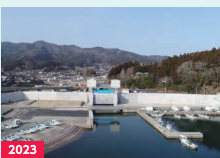
2023 綾里漁港海岸災害復旧（岩手県）
