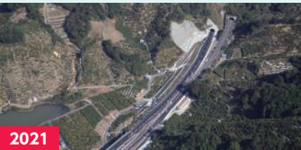
2021 柳瀬トンネル（和歌山県）
