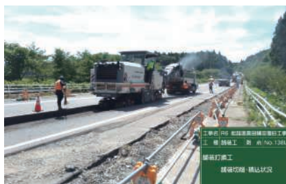
能登復興施工状況
