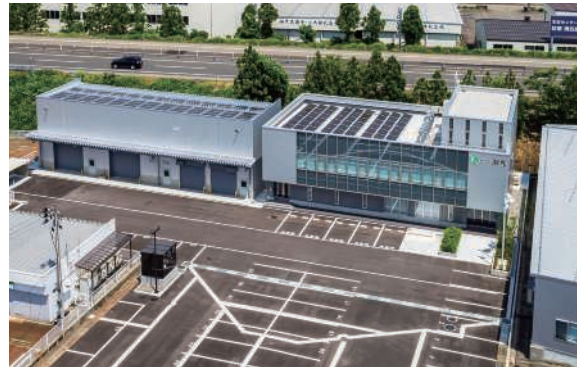
「ZEB」で建設した株式会社興和中越支店（新潟県長岡市）
