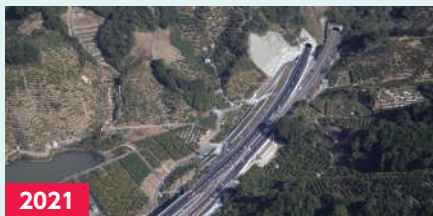
2021 第一白川橋りょう復旧 (熊本県)
