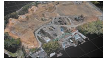
造成工事における点群データ例
