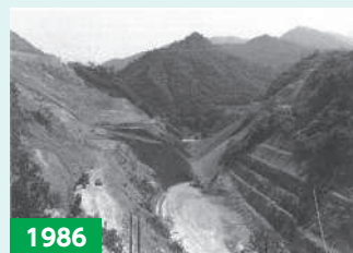
1986 初の大規模ダム工事である破間川ダム
