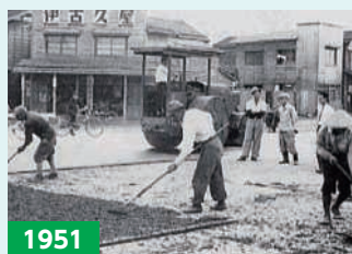
1951 舗道部発足当時 長岡市大手通りの舗装工事
