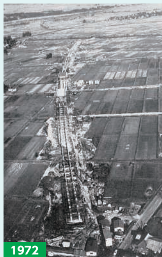
1972 上越新幹線九日町高架橋（第2工区）工事
