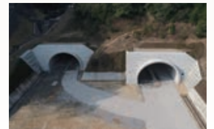
2023 東海環状岐阜山県第一トンネル(岐阜県)
