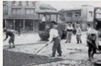
1951 舗道部発足当時 長岡市大手通りの舗装工事
