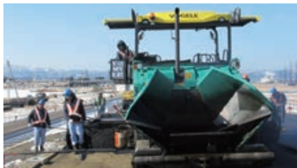
「おとなしくん」を活用した施工
