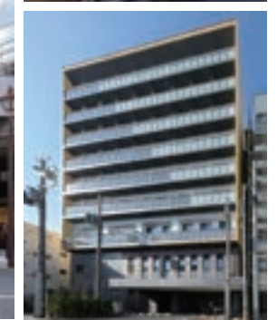
(仮称)新北海道教育会館新築工事 (北海道)
