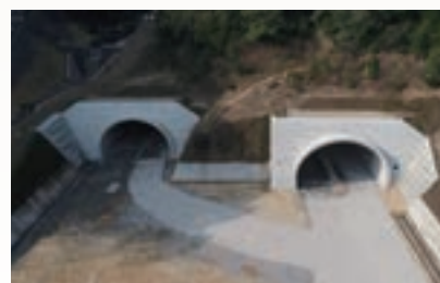
2023 東海環状岐阜山県第一トンネル(岐阜県)
