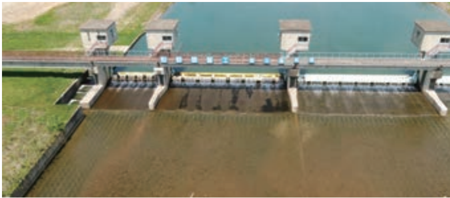
会津北部農業水利事業 松野頭首工補修工事(福島県)
