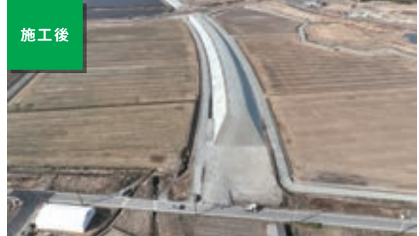
道路橋りょう整備(再復)工事(道路改良)(福島県)
