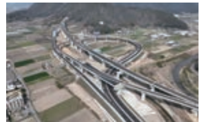
東海環状山県舗装工事(岐阜県)
