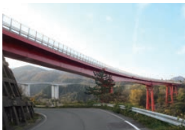
塗装塗替工事が完了した米山大橋(新潟県柏崎市)
