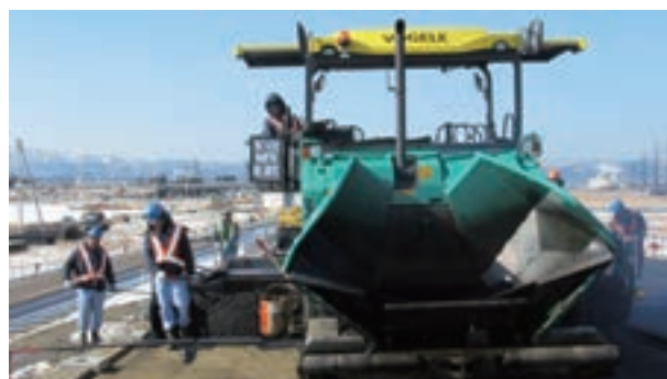
「おとなしくん」を活用した施工
