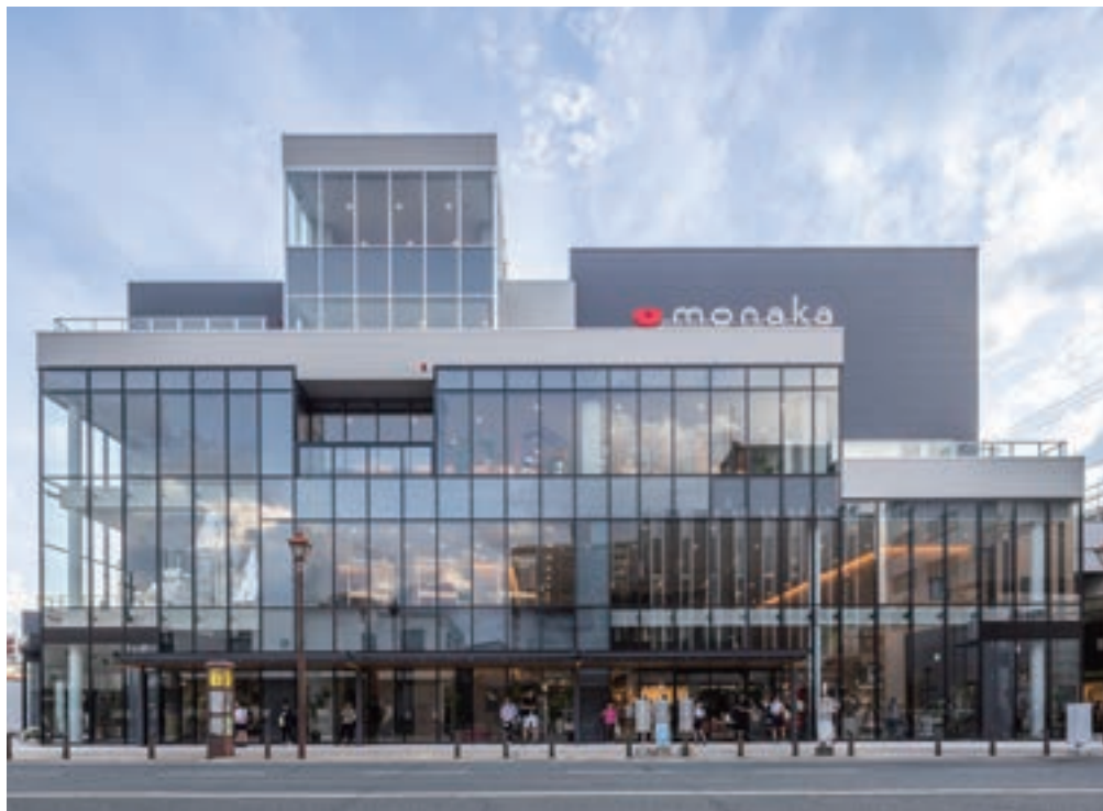
中ノ橋通一丁目地区第一種市街地再開発事業施設建築物(西街区)新築工事(岩手県)
