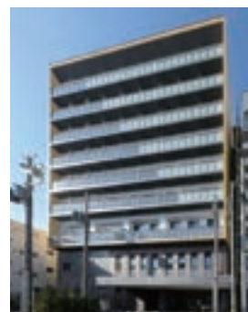
(仮称)北海道教育会館新築工事 (北海道)
