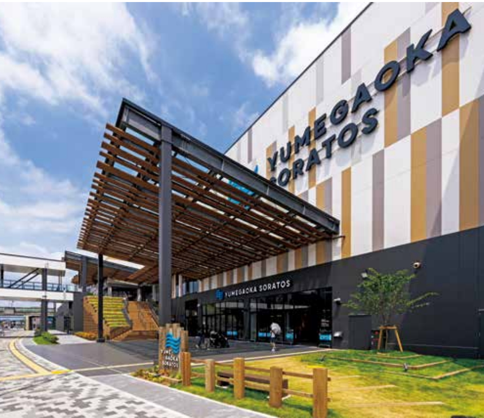
ソラトス1 エントランスと上階へ誘導する外部階段
