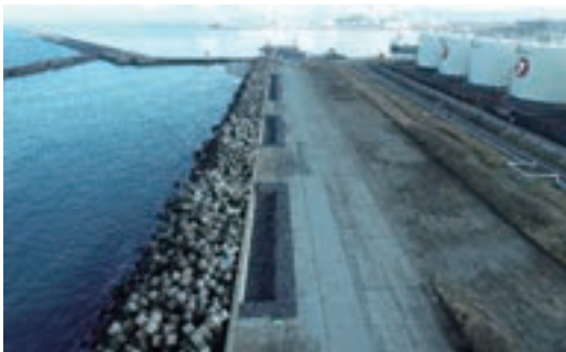
新潟県 様 新潟港海岸（松浜地区）西埋立地護岸改良（その3）工事（新潟県）
