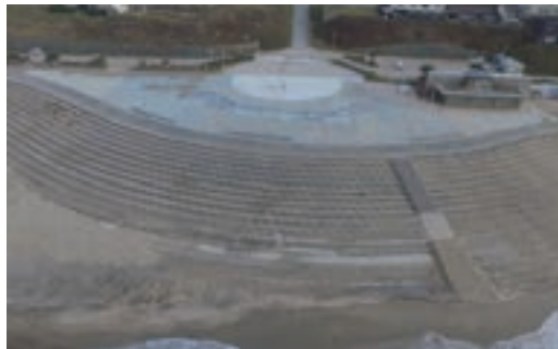
新潟県 様 岩船港3年災害海岸災害護岸復旧工事（新潟県）
