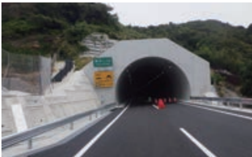
西日本高速道路株式会社関西支社 様 湯浅御坊道路 柳瀬トンネル他1トンネル工事（和歌山県）
