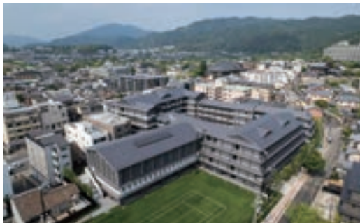
住友商事株式会社 様 （仮称）元白川小学校跡地再開発計画新築工事（京都府）
