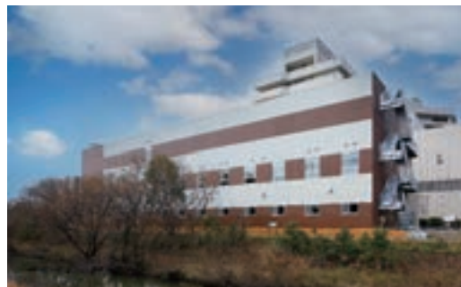
国立大学法人 岐阜大学 様 手術棟施設および事業者提案施設整備運営等事業（建設工事）（岐阜県）
