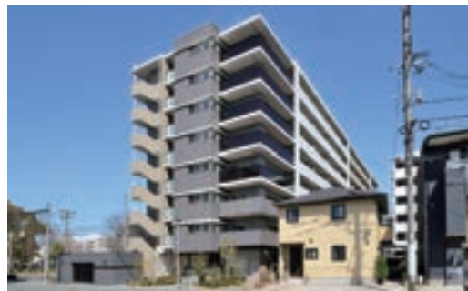
穴吹興産株式会社 様 （仮称）アルファスマート九品寺新築工事（熊本県）
