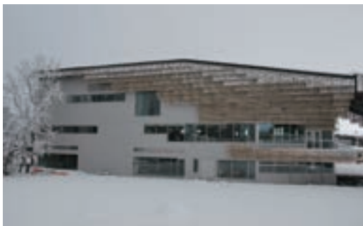
三条市 様 図書館等複合施設建設本館建築本体工事（新潟県）
