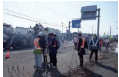
GNSSマシンコントロール切削(国交省見学会の様子)
