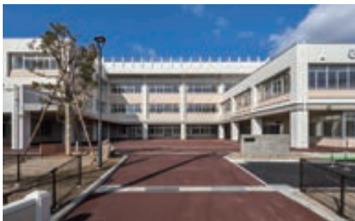
新潟市 様 潟東小学校移転改築工事（新潟県）
