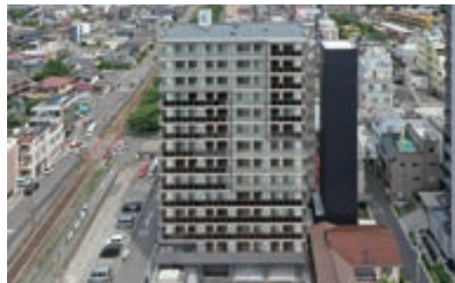
穴吹興産株式会社 様 （仮称）アルファステイツ住吉Ⅱ 新築工事（長崎県）
