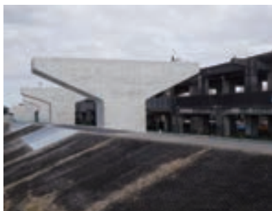
千葉県 様 社会資本総合交付金工事 （仮称土屋橋本線P10・P11橋脚）（千葉県）
