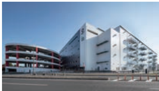
浦和美園特定目的会社 様 （仮称）DPL浦和美園 新築工事（埼玉県）
