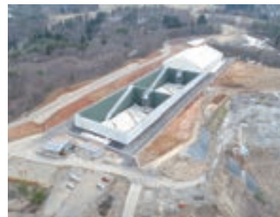
長岡市 様 長岡市新一般廃棄物最終処分場（仮称）建設工事 （新潟県）
