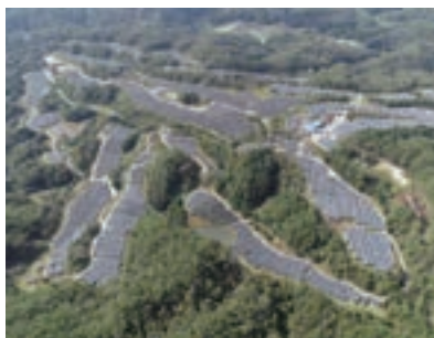
株式会社日立製作所 様 SGET広島メガソーラー発電所建設工事（広島県）
