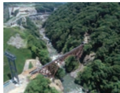
エム・エムブリッジ株式会社 様 第一白川橋りょう復旧工事（その2-1）（熊本県）
