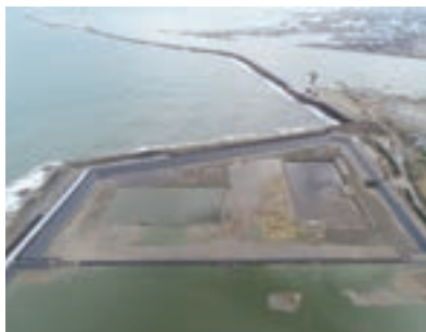
新潟県 様 新潟港（西港区）廃棄物埋立護岸管理淤土砂樹築堤 その8工事（新潟県）
