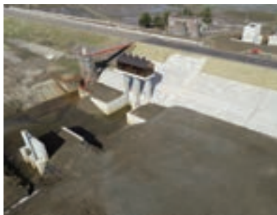
国土交通省北陸地方整備局 様 島崎川樋管・排水機場改築その1工事（新潟県）
