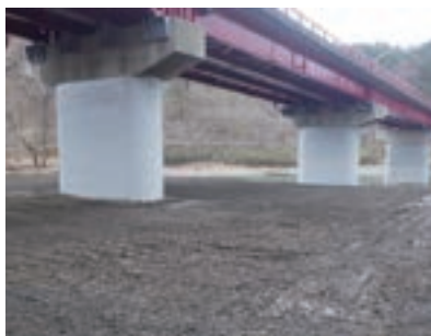
岩手県 様 一般国道455号袋野大橋橋梁耐震補強・ 補修（下部工）工事（岩手県）
