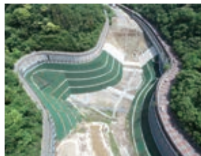
神奈川県 様 平成31年度かながわ環境整備センター しゃ水施設整備工事（神奈川県）
