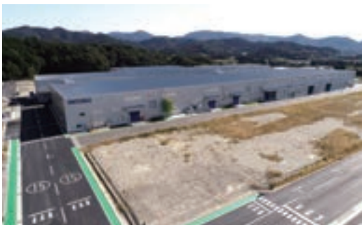
株式会社イノアックコーポレーション 様 イノアック八名第2工場 新築工事（愛知県）
