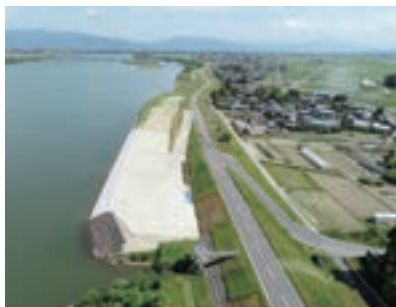
国土交通省北陸地方整備局 様 蔵岡低水護岸工事（新潟県）
