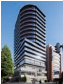
秋田不動産サービス株式会社 様 秋田版CCRC拠点整備事業（中通二丁目地区優良建築物等整備事業） 施設建築物新築工事（秋田県）
