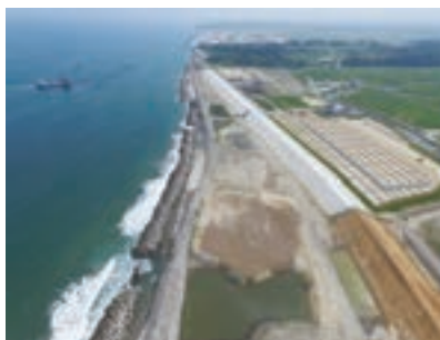
福島県 様 公共災害復旧（再復）工事（海岸）（福島県）
