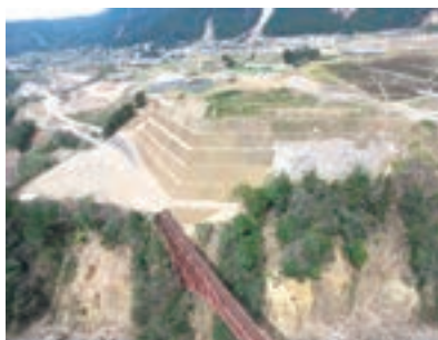
国土交通省九州地方整備局 様 立野地区斜面掘削その他工事（熊本県）
