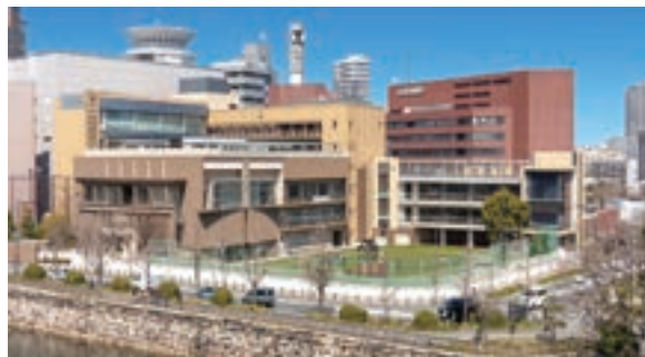
学校法人追手門学院 様 追手門学院小学校新東館建設工事及び付帯工事 (大阪府)
