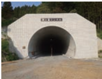
新潟県 様 主要地方道佐渡一周線竹ヶ鼻バイパス （仮称）竹ヶ鼻トンネル工事（新潟県）
