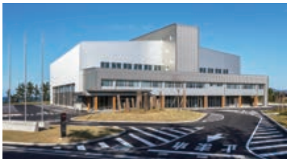
上越市 様 (仮称) 上越市体操アリーナ新築工事 (新潟県)
