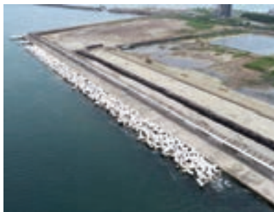
新潟県 様 新潟港（西港区） 護岸災害復旧（廃棄物埋立護岸2号）工事（新潟県）
