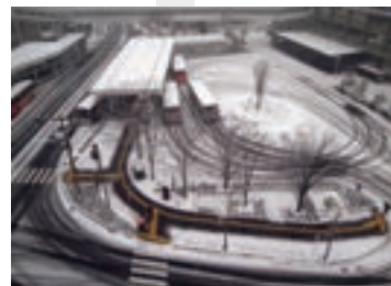
下水熱利用による歩道融雪状況
