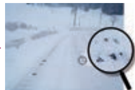
タイヤの通行で圧雪が剥がれ路面が露出
