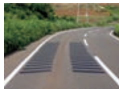
タイヤの通行部分に施工
