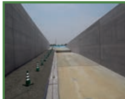
千葉県 様 社会資本整備総合交付金（U型擁壁工）（千葉県）
