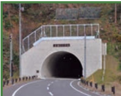
新潟県 様 一般国道403号総合交付金（国道改築）（仮称）新大倉トンネル工事（新潟県）
