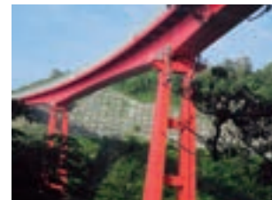
国土交通省発注 米山大橋塗替塗装工事
