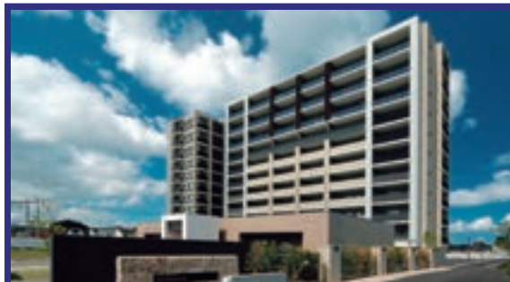
株式会社ランディック アソシエイツ 様 （仮称）アソシア福岡マンション工事（福岡県）
