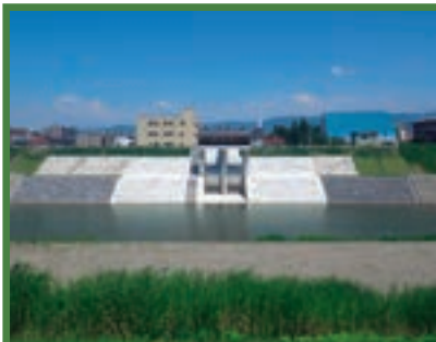
国土交通省 様 柿川放水路排水樋門新設工事（新潟県）
