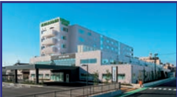
白根保健生活協同組合 様 白根健生病院移転新築工事（新潟県）
