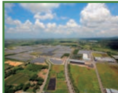
新潟県 様 H24東光建2第7号 新潟東部太陽光発電所（3号系列）建設工事（新潟県）
