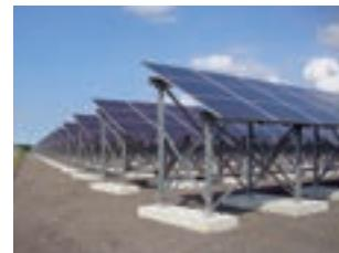
発電施設内敷砂利 再生路盤材を使用
