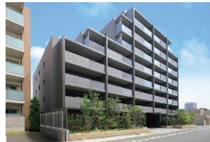
マストスクエア東白壁／愛知県 発注者：積水ハウス不動産中部㈱ ■概要：RC造、8階、分譲マンション 31戸、延床面積3,025.09㎡
