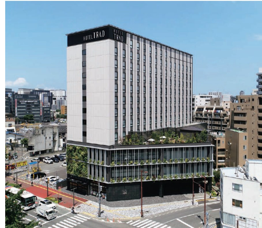
ホテルトラッド博多／福岡県 発注者：㈱えんホールディングス ■概要：S造、12階、複合ビル(店舗、オフィス、ホテル、タワーパーキング)1棟、209室、延床面積11,244.12㎡
