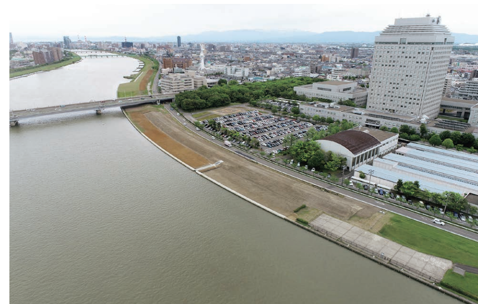
信濃川下流東新潟地区河道掘削及び新光町やすらぎ堤その9外工事 ／新潟県 発注者：国土交通省北陸地方整備局 ■概要：浚渫工17,000㎡ 築堤盛土251m 矢板護岸170m 地盤改良工 静的締固方式 改良長L=16.0m 153本 改良長L=11.7m 642本 樋管改築1式 仮設工1式
