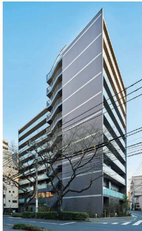
南大塚寮／東京都 発注者：㈱日本エスコン ■概要：RC造、10階、寄宿舎 105戸、延床面積2,495.26㎡
