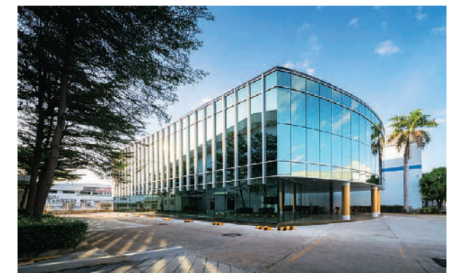
PLASESS Hi-Tech Co.,Ltd. (Hi-Tech Industrial Estate, Ayutthaya)
