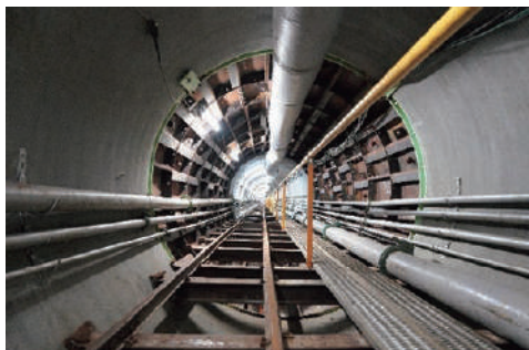
施工状況(推進管からセグメントへ)
