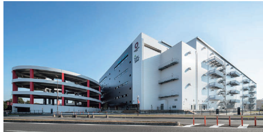
DPL浦和美園／埼玉県 発注者：浦和美園特定目的会社 ■概要：PCaPC構造、杭頭免振工法 延床面積91,852.26㎡
