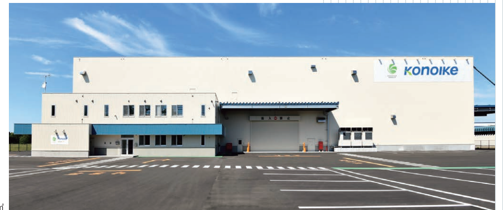
鴻池運輸 新千歳流通センター ／北海道 発注者：鴻池運輸株式会社 ■概要：S造、2階、延床面積17,031.20㎡
