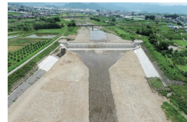
千曲川笠原床固工災害復旧工事 ／長野県 発注者：国土交通省北陸地方整備局 ■概要：作業土工1式 消波根固めブロック(6t型)製作据付3,345個 仮設工1式
