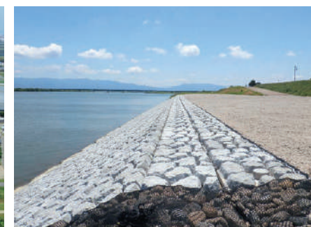
蔵岡低水護岸工事／新潟県 発注者：国土交通省北陸地方整備局 ■概要：多自然型ブロック張1,000㎡ 大型連節ブロック張1,065㎡ 粗朶沈床960㎡
