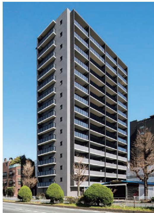
ヴィークオレレジデンス名古屋駅／愛知県 発注者：宝交通㈱ ■概要：RC造、15階、分譲マンション 56戸、延床面積4,545.36㎡
