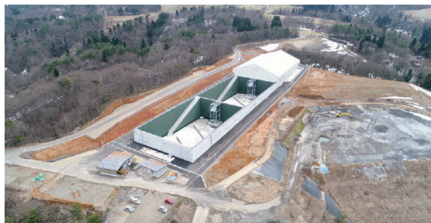
長岡市新一般廃棄物最終処分場(仮称)建設工事 ／新潟県 発注者：新潟県長岡市
