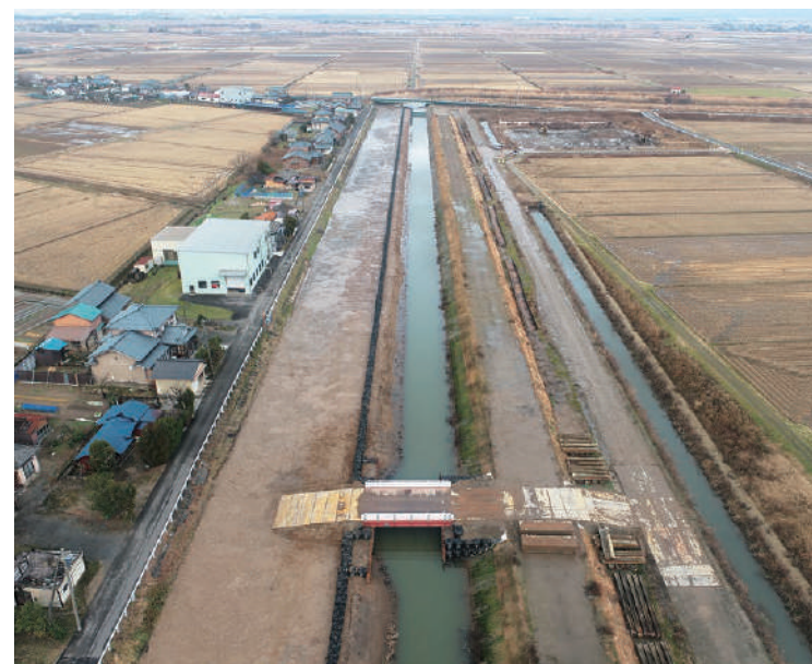
一級河川大通川防安(3か年)掘削本川切替工事／新潟県 発注者：新潟県 ■概要：延長1,017.7m 掘削工12,600㎡ 盛土工510㎡ 仮締切工1式
