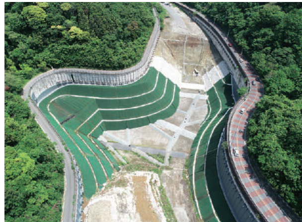
平成31年度かながわ環境整備センターしゃ水施設整備工事／神奈川県 発注者：神奈川県
