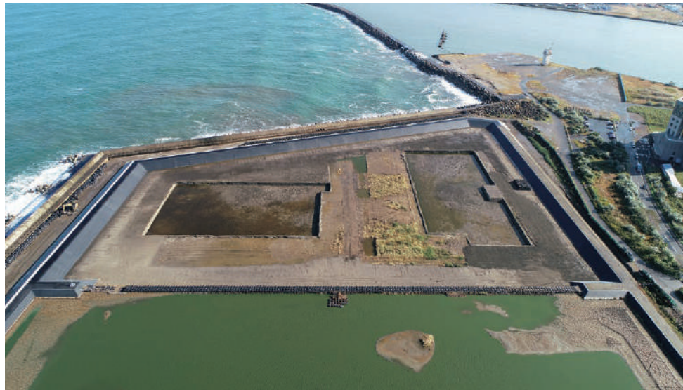
新潟港(西港区)廃棄物埋立護岸管理 浚渫土砂埋築堤その8工事 ／新潟県 発注者：新潟県
