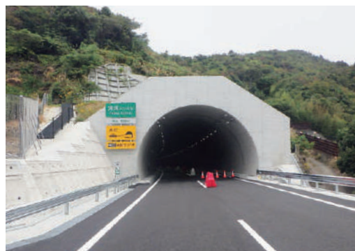
湯浅御坊道路柳瀬トンネル他1トンネル工事／和歌山県 発注者：西日本高速道路株式会社関西支社 ■概要：工事延長 L=2,139m。 トンネル延長 L=754m(湯浅トンネル L=621m、柳瀬トンネル L=133m) 橋梁下部工(橋台4基、橋脚8基) 基礎工(ベント杭φ1,200 L=60m、深礎杭φ2,500 L=15m) 既設橋撤去工1橋
