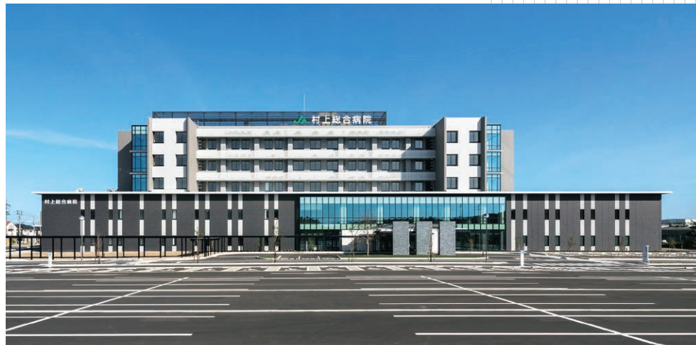
村上総合病院／新潟県 発注者：新潟県厚生農業協同組合連合会 ■概要：RC造、5階、塔屋2階（屋上ヘリポート） 病院棟、エネルギー棟、車庫棟、ポンプ室、 院内保育施設 延床面積22,554.67㎡
