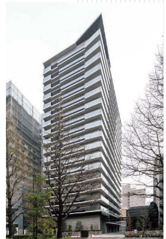
ブラウドタワー仙台晩翠通サウス／宮城県 発注者：野村不動産㈱ ■概要：RC造、19階、分譲マンション 99戸、延床面積9,007.22㎡
