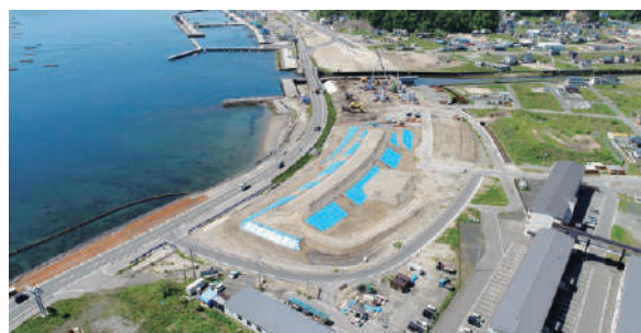
山田漁港海岸高潮対策(防潮堤その1)工事／岩手県 発注者：岩手県
