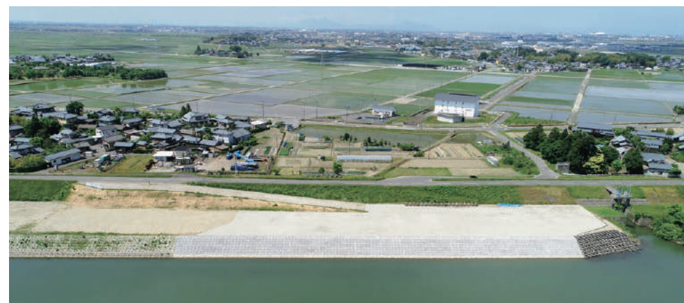
蔵岡低水護岸工事／新潟県 発注者：国土交通省北陸地方整備局 ■概要：多自然型ブロック張1,000㎡ 大型連節ブロック張1,065㎡ 粗朶沈床960㎡
