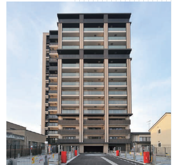
プレミスト郡山GreenMarks／福島県 発注者：大和ハウス工業㈱ ■概要：RC造、15階、分譲マンション 58戸、延床面積5,315.67㎡
