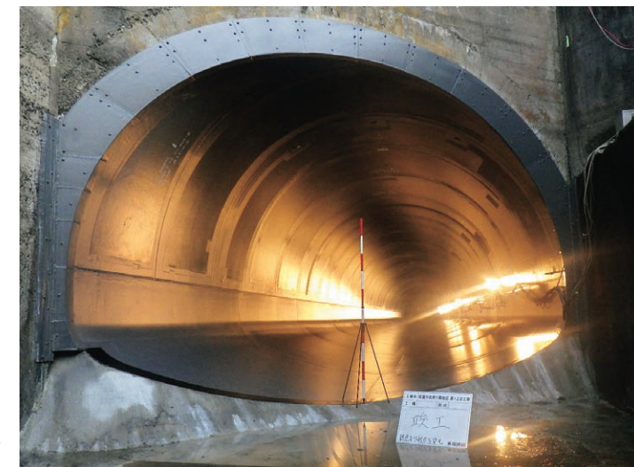
県宮かんがい排水事業(一般(耕)) 信濃川右岸(1期)地区第12次工事／新潟県 発注者：新潟県
