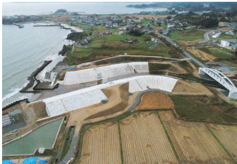
沖ノ田川河川災害復旧工事(その2)／宮城県 発注者：宮城県 ■概要：復旧延長L=340.0m 築堤盛土工V=85,120㎡ 法面被覆工A=13,913㎡ 樋管工N=2基 矢板工N=1,305枚
