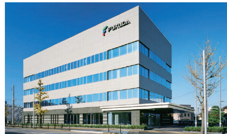
平成28年 福田組本社社屋
