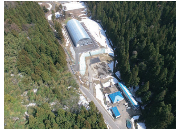
一般廃棄物最終処分場建設工事／新潟県 発注者：新潟県糸魚川市
