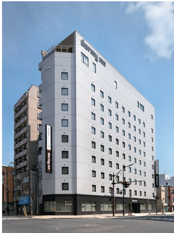
天然温泉さんさの湯 ドーミーイン盛岡／岩手県 発注者：㈱中央住宅産業 ■概要：RC造、10階、169室、延床面積5,612.63㎡
