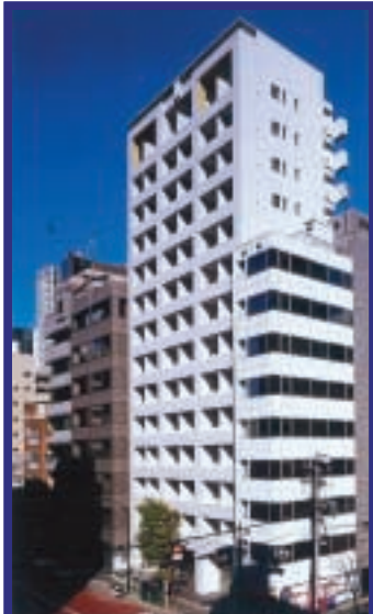
(有)デュープレックス・シックス 様 神谷町デュープレックス新築工事(東京)
