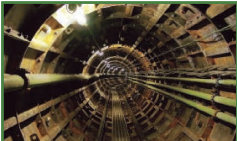
千葉県 様 手賀沼流域下水道管渠築造工事(千葉)
