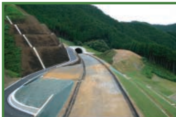
近畿地方整備局 様 春日和田山道路岡見トンネル工事(兵庫)
