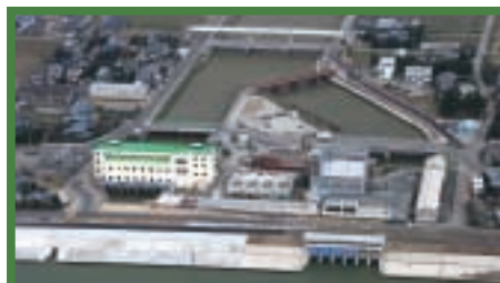
北陸農政局 様 亀田郷農業水利事業 親松排水機場建設工事(新潟)
